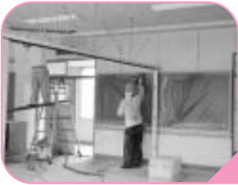
▲工事中の教室
